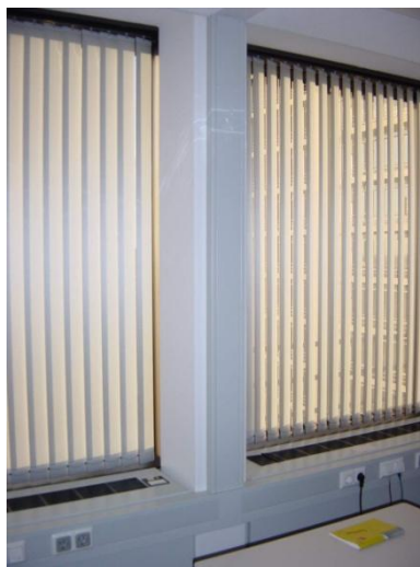
Brüstungskanal mit Sticheinbindung
