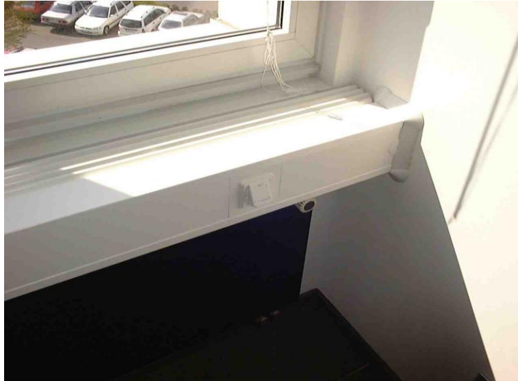
Brüstungskanal, Montage vor Heizkörper
